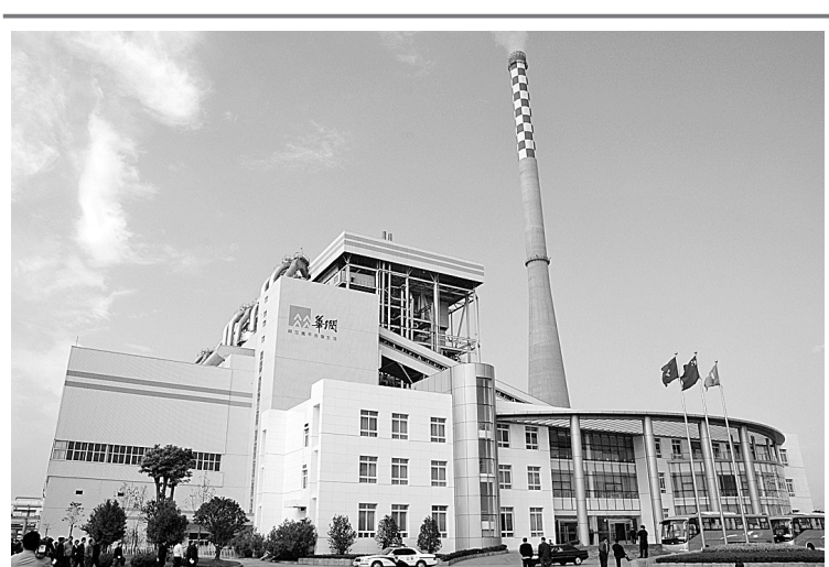
华润电力的2×60万千瓦机组项目是登封下半年的重点项目。
